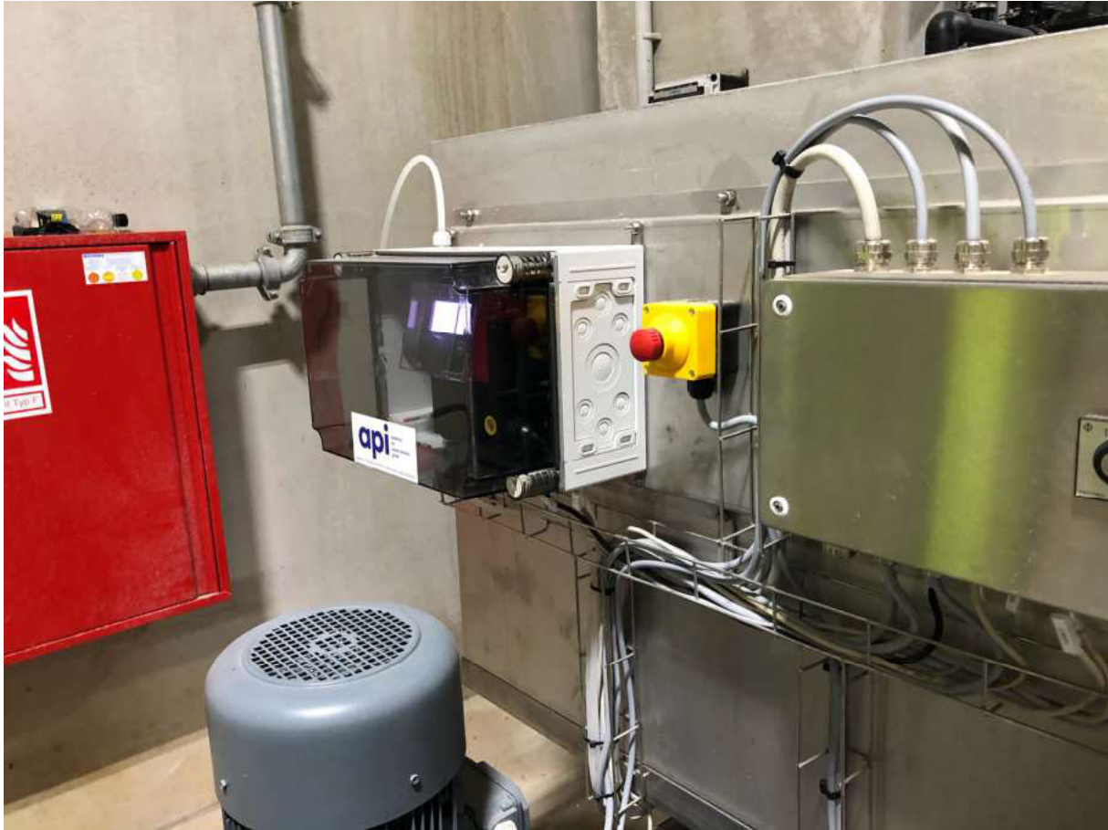
Abbildung 32: Dosiereinheit, Not-Aus-Schalter
