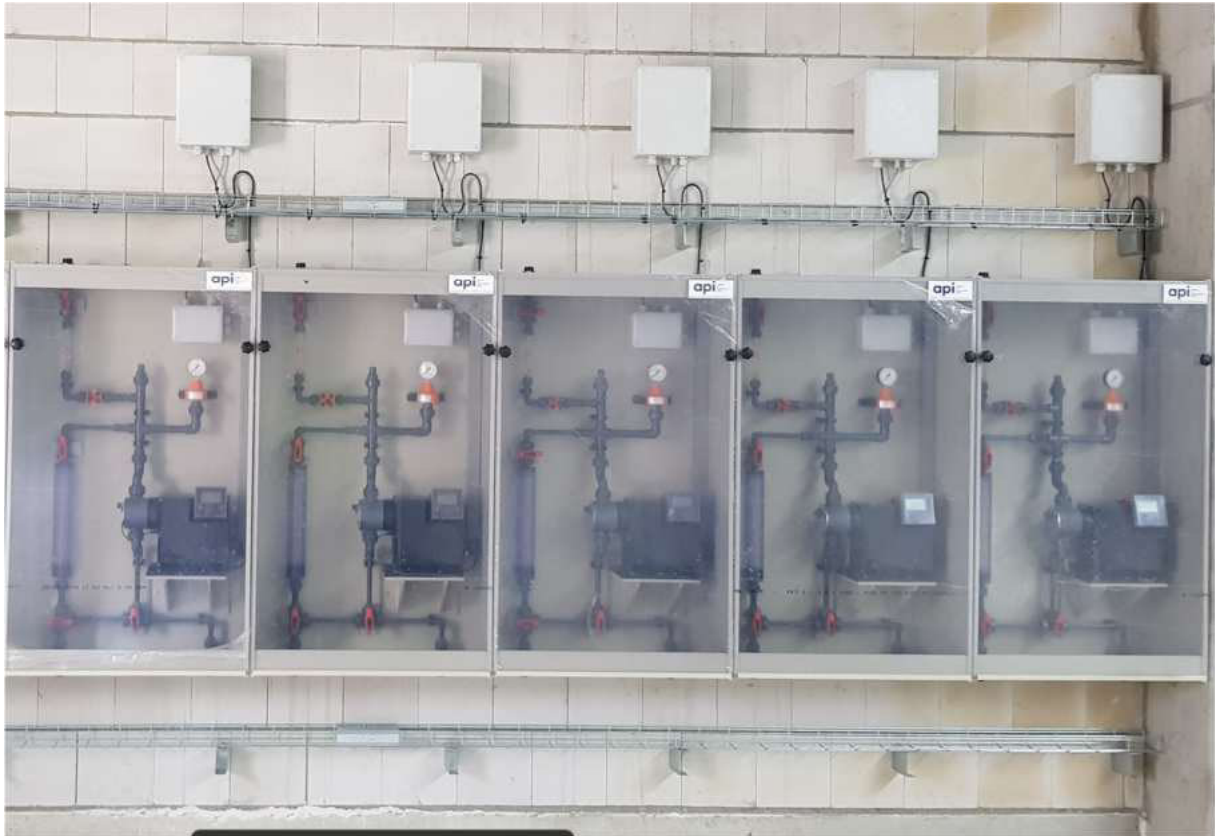
Abbildung 27: Dosierpumpenmodule
