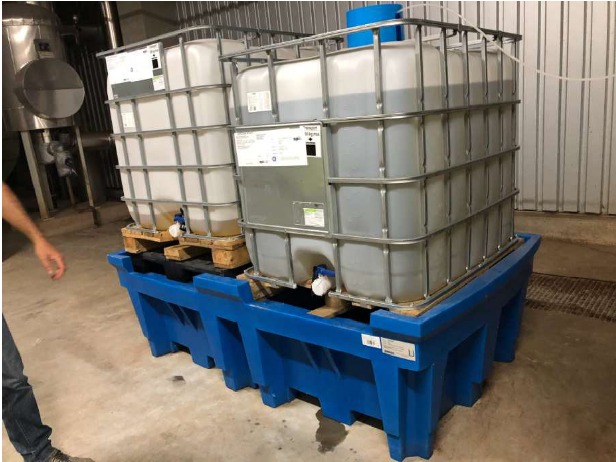
Abbildung 28: Auffangwanne DENIOS mit bauaufsichtlicher Zulassung bzw. einer Wanne mit Einzelnachweis
