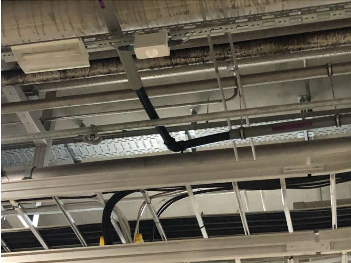
Abbildung 18: Rohrleitungen im Rohr-im-Rohr-System, in der Biegung offen
