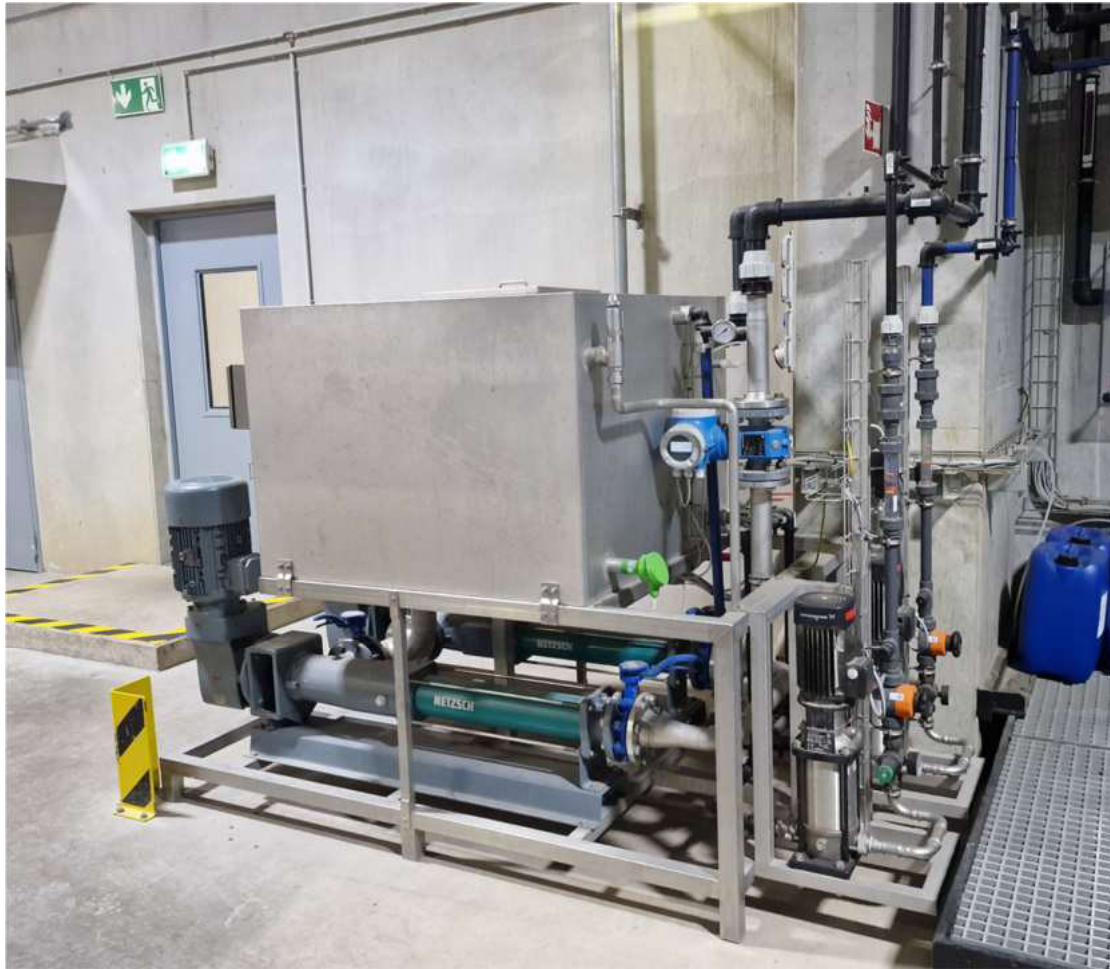
Abbildung 3: Reaktionseinheit für Monochloramin mit Dosiereinheiten für das Kreislaufwasser und die Frischwasserzufuhr
