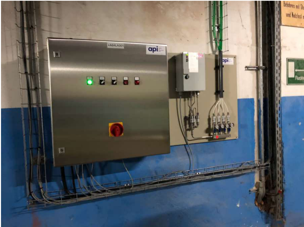
Abbildung 24: Vakuum-Leckageanzeigesystem und Heizung für Außenleitung (doppelwandig)
