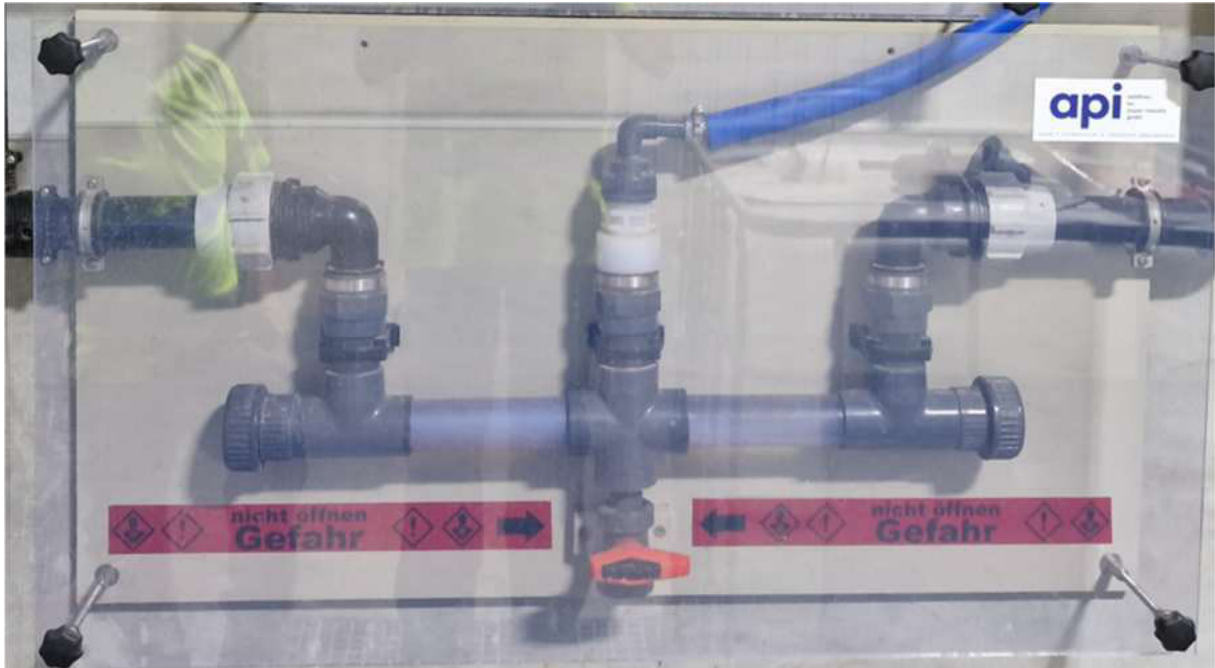
Abbildung 5: Reaktionseinheit NaOCl (Injektionskammer)
