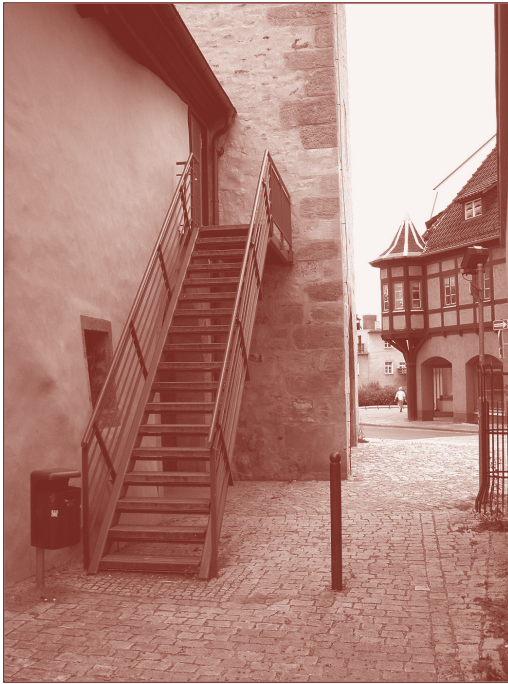
Für Besucher zugänglich ist das Darrtor über eine nachträglich angebaute Außentreppe an der Südfassade „Hinter dem Graben“ und eine Türöffnung an der Stelle des früheren Fensters über dem Durchgang.
